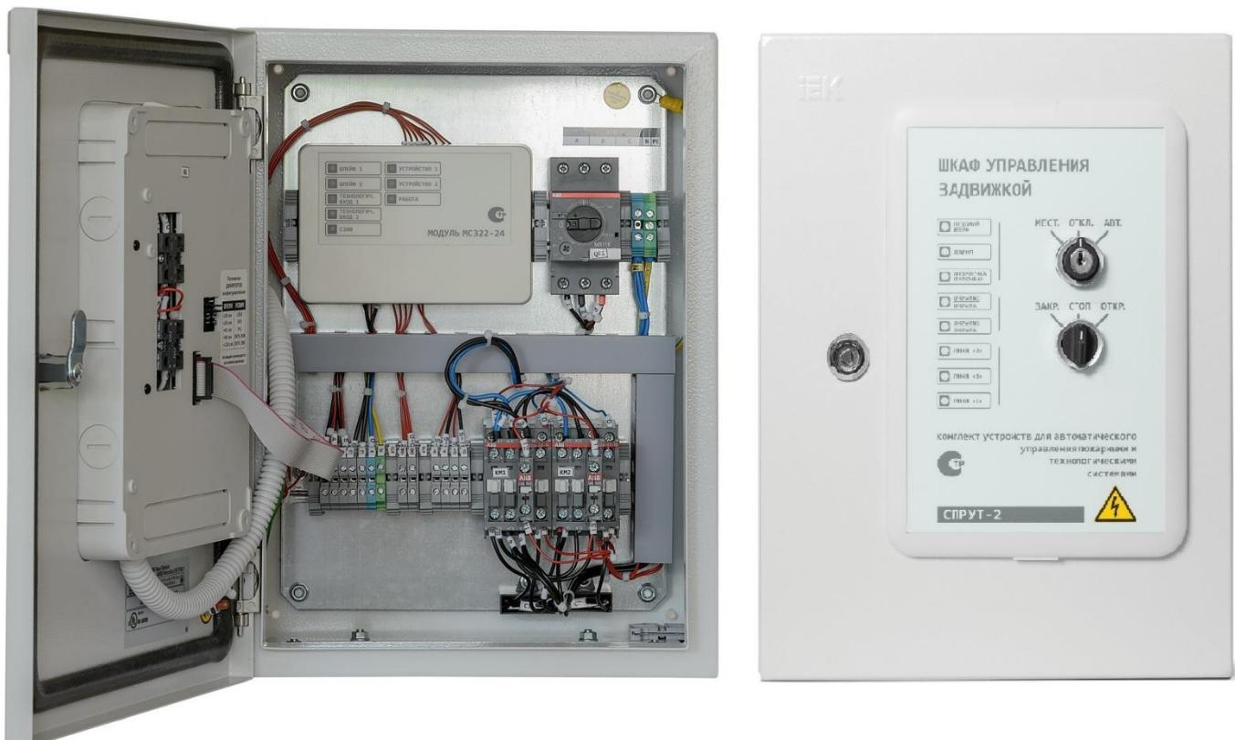
На лицевой панели ШУЗ-С300 расположены светодиоды индикации, «Переключатель режима работы» с ключом и «Переключатель управления задвижкой в местном режиме». На обратной стороне дверцы шкафа имеется отверстие для доступа к джамперам конфигурирования.
