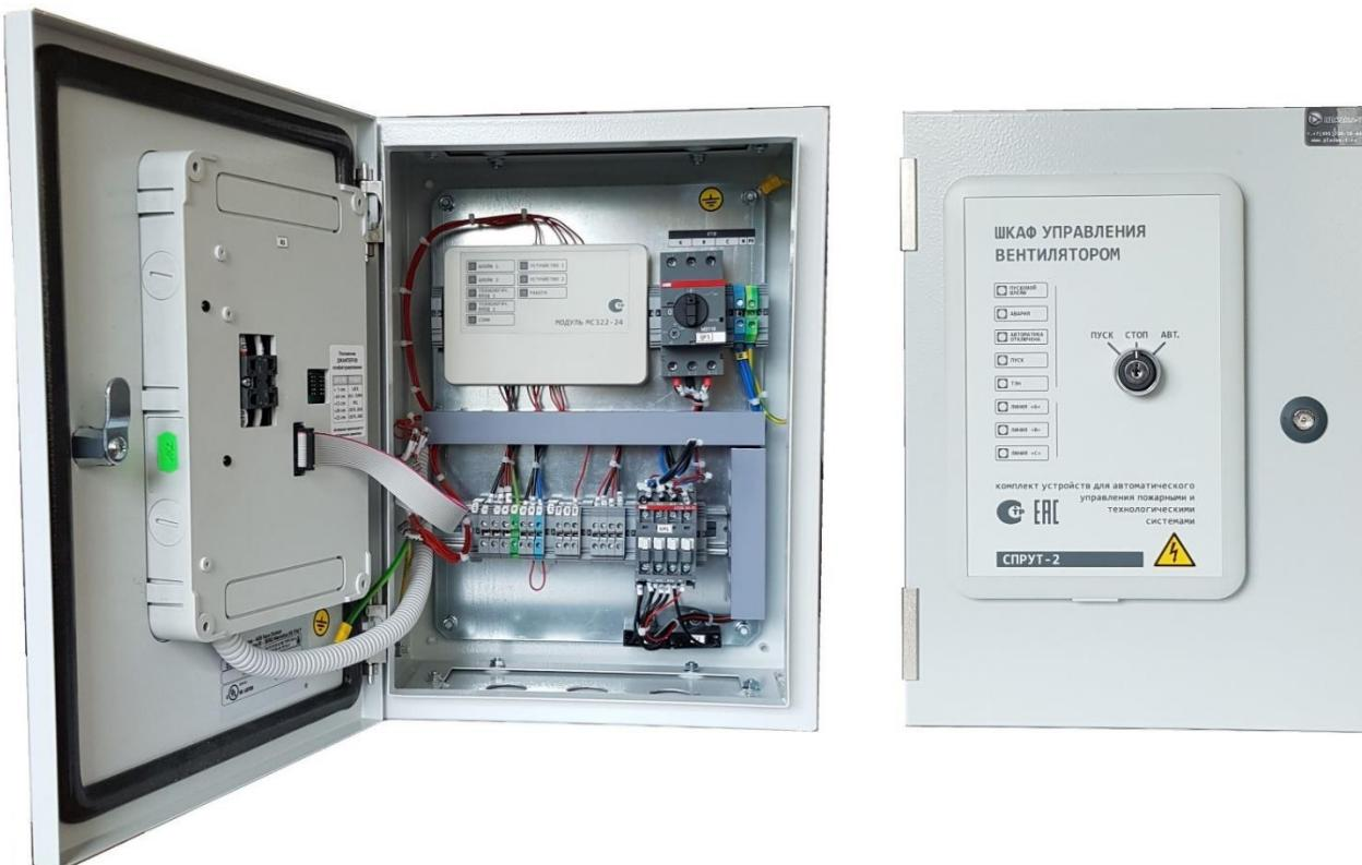
На лицевой панели ШУВ-С300 расположены светодиоды индикации и «Переключатель режима работы» с ключом. На обратной стороне дверцы шкафа имеется отверстие для доступа к джамперам конфигурирования.
